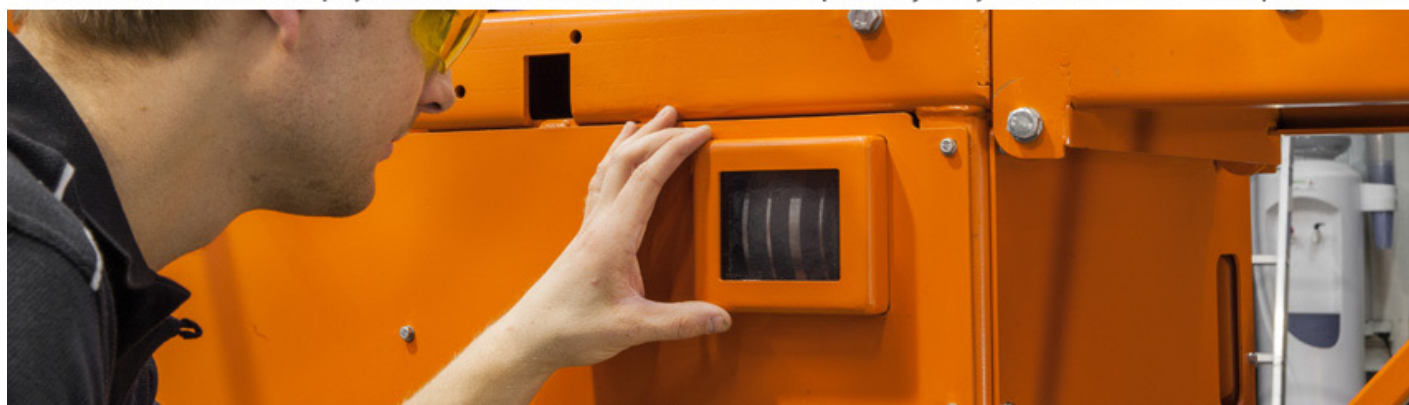
La ventana de visualización permite al operario comprobar el estado de la correa.
